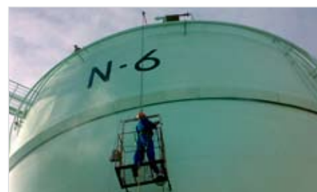
...и после. Покрытие сохранилось великолепно
